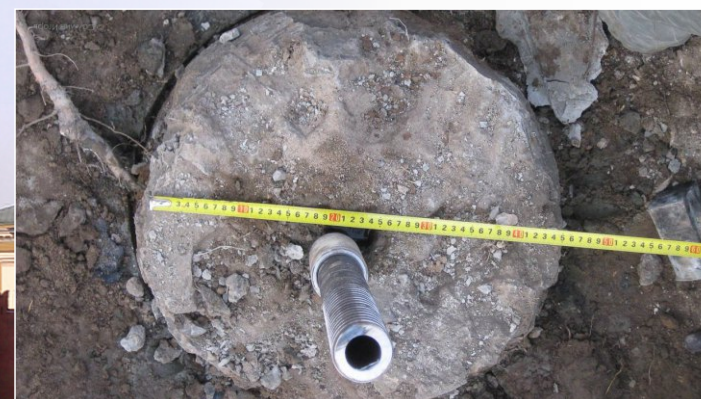
Применение технологии AtlantJet при устройстве анкеров, г. Москва
